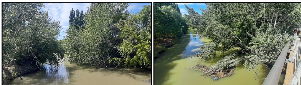
Extracción, poda y raleo en inmediaciones al puente Hendre (Trelew)
